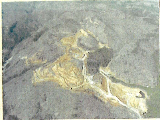
東面より現場を撮影
