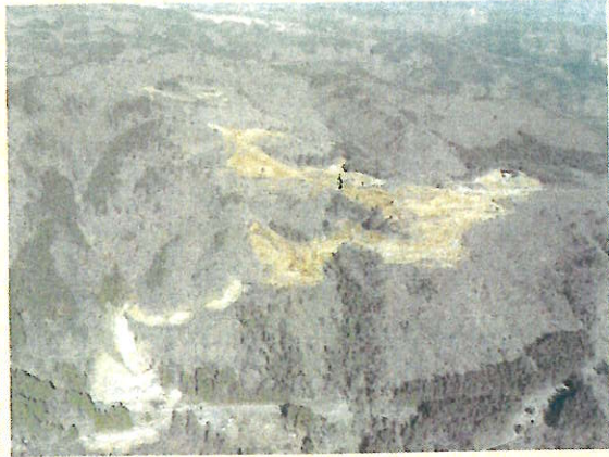
南面より現場を撮影
